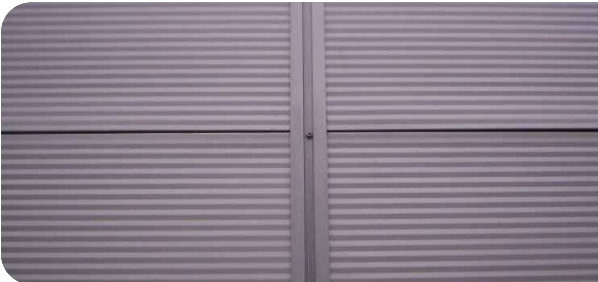
Resim 5.28 Yatay cephe paneli arası hut profili
