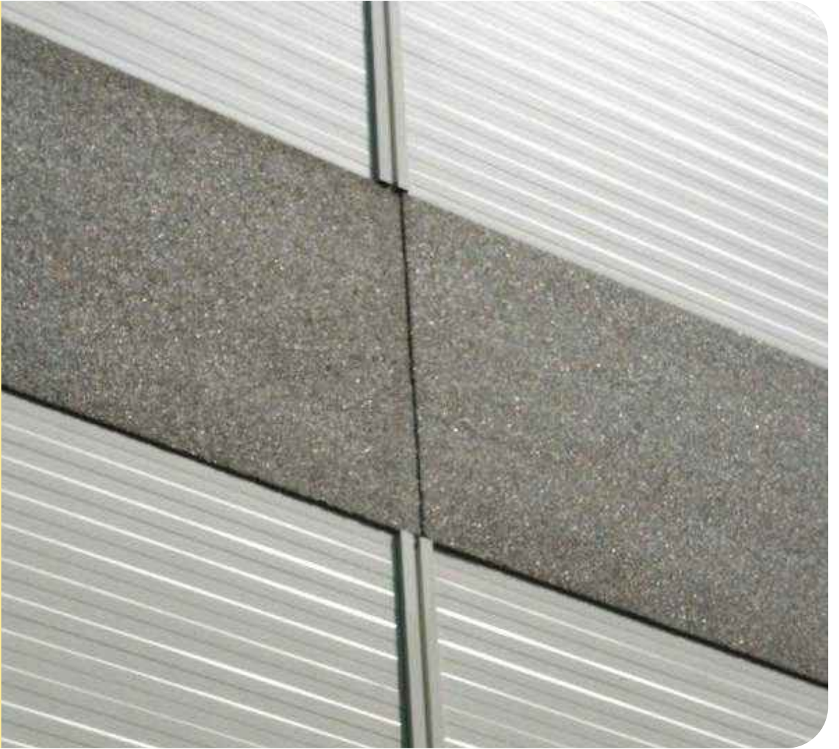
Resim 5.29 Cephe dilatasyonu
